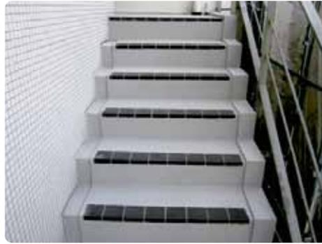
マンションの外階段。ひび割れが多数見られるためSクリートクラック工法(表面被覆)による補修を実施。
