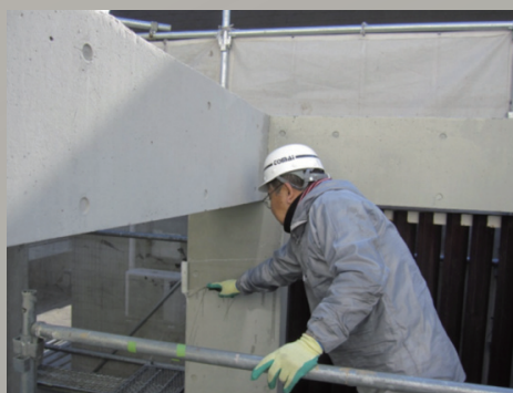
Sクリートアップ(ケイ酸塩系浸透性コンクリート改質材)を全面に2回塗布。Sクリートアップはコンクリートの改質・強化と同時に防水性を向上させる。
