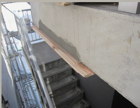
補修モルタルで再成形。
