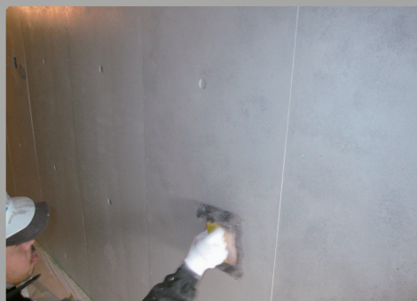
Sクリートカラー3回目の塗布。3回目は黒顔料 を混入し、目塗工N-70程度に調色し、フェルト 材にて叩き塗り。
