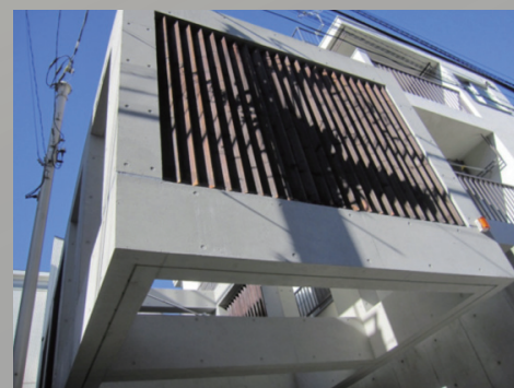
施工終了。美観がよみがえり、長期に美観を維持し、コンクリートを保護します。
