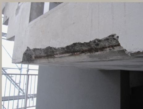
浮き部をはつり、ペガサビンにて鉄筋の防錆処理を施した後、Sクリートアップを塗布。Sクリートアップの効果によりコンクリートの改質・緻密化、アルカリ性回復。また、補修モルタルとの接着性が增强される。
